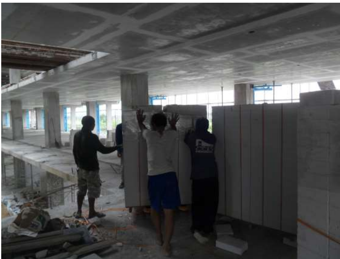
การเตรียมอิฐเพื่อก่อผนัง ควรขนย้ายด้วยอุปกรณ์
