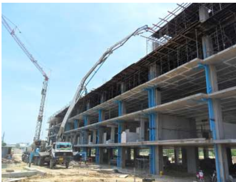
รถคอนกรีต ห้ามหน้างาน เช็กล้มคอนกรีต และเก็บลูกปูนเพื่อนำไปทดสอบคอนกรีต
