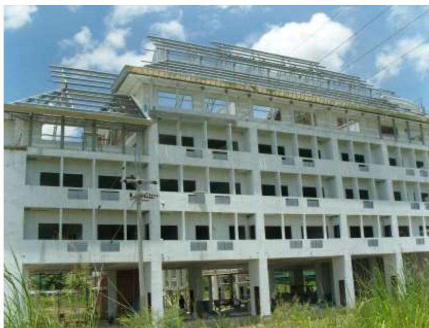
กรณีโครงหลังคาโครงถักให้ทำการเชื่อมด้านล่างก่อนยกขึ้นไปเชื่อมต่อด้านบน
