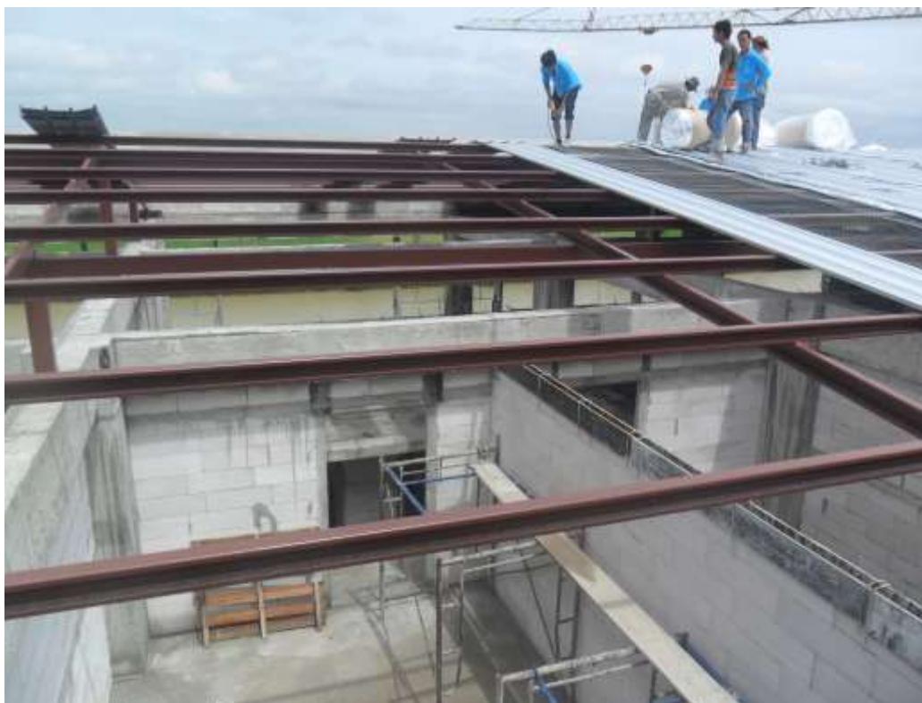
การทำโครงหลังคาให้เชื่อมอย่างแน่นหนา พร้อมทำสีกันสนิมและสีน้ำมัน
