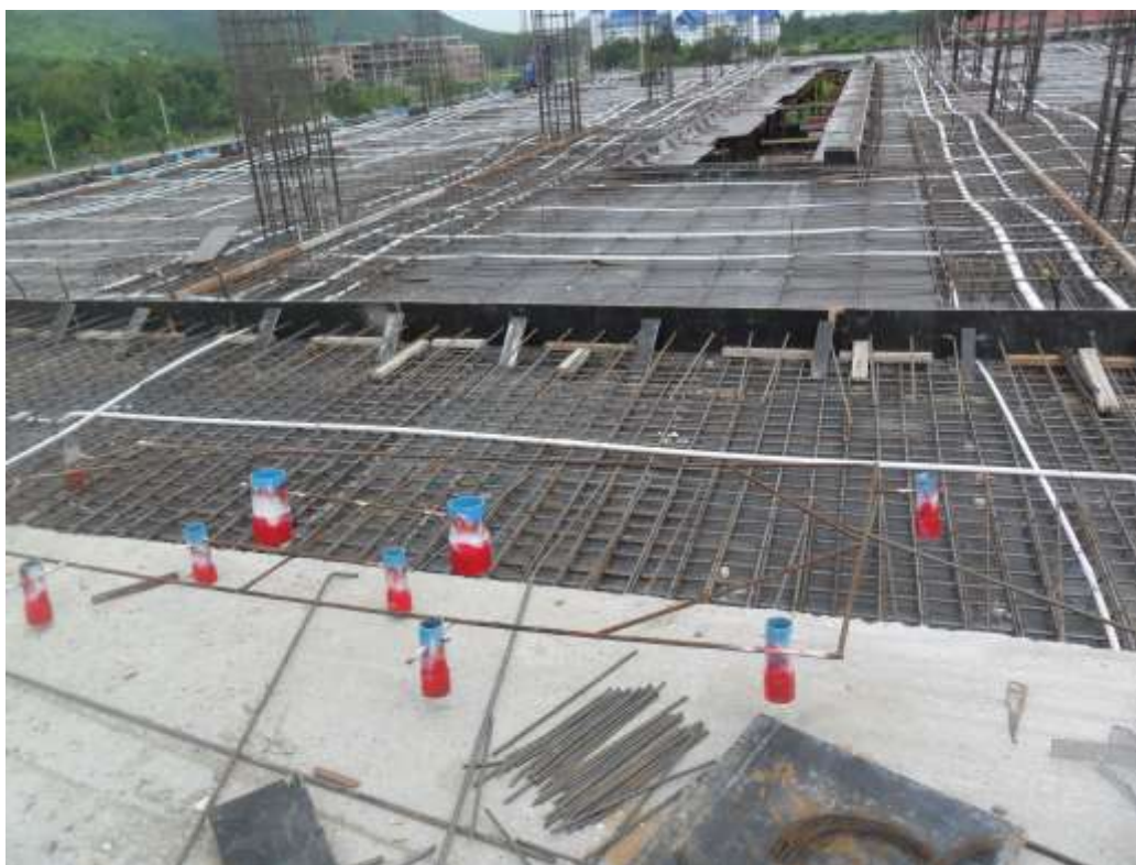
การตั้งแบบวางลวด เหล็กพื้น post tension
