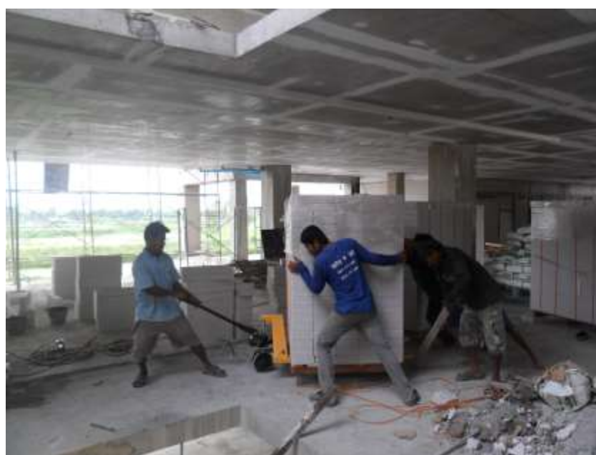
การเตรียมอิฐเพื่อก่อผนัง ควรขนย้ายด้วยอุปกรณ์
