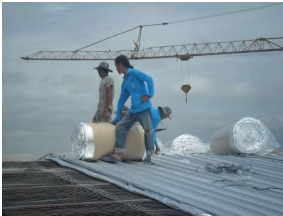
การวางฉนวนกันความร้อนพร้อมมุงด้วย หลังคาแผ่นเหล็กที่รื้อถอน
