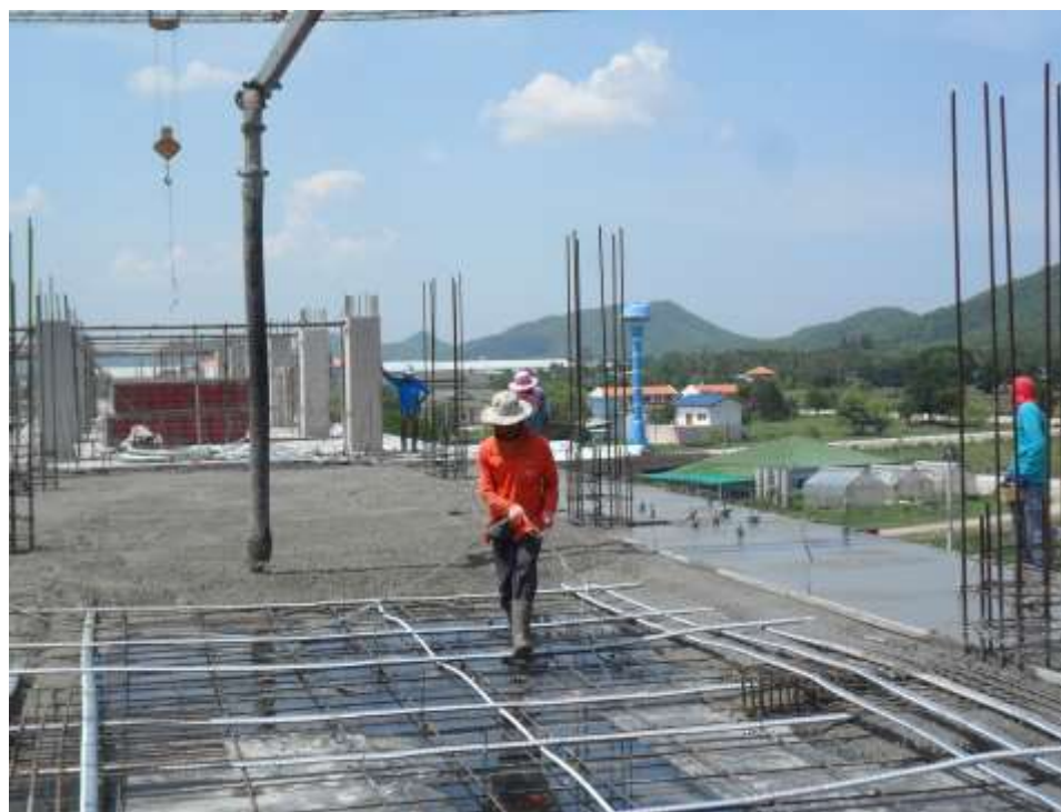
การเทคอนกรีต เหน้ที่แบบ มีคนงานจ้คอนกรีต
