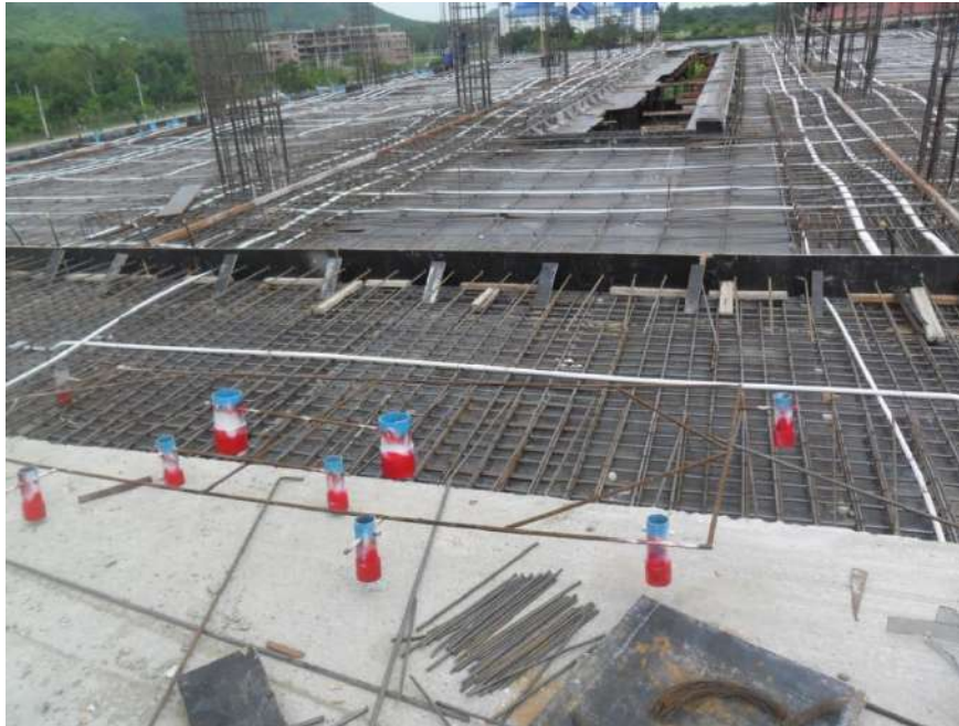
การตั้งแบบวางลวด เหล็กพื้น post tension
