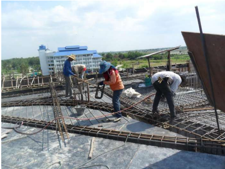
กรณีการวางเหล็กหลายทางให้ตรวจสอบในแบบพิมพ์เขียว
