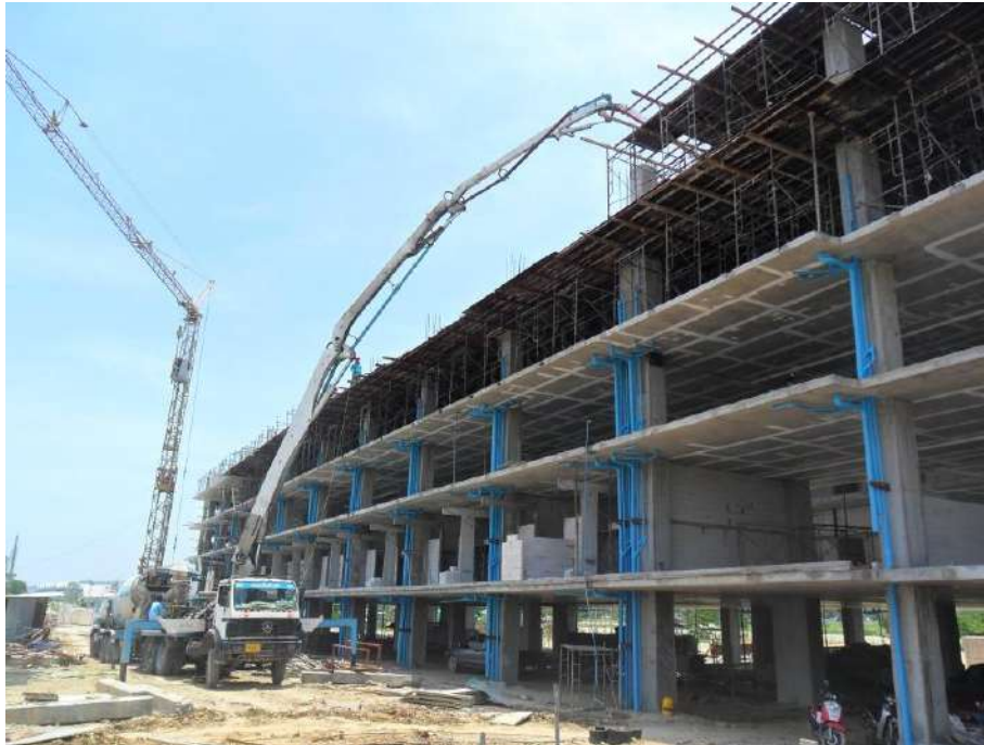
รถคอนกรีต ห้ามเทน้ำหน้างาน เช็คล้มคอนกรีต และเก็บลูกปูนเพื่อนำไปทดสอบคอนกรีต
