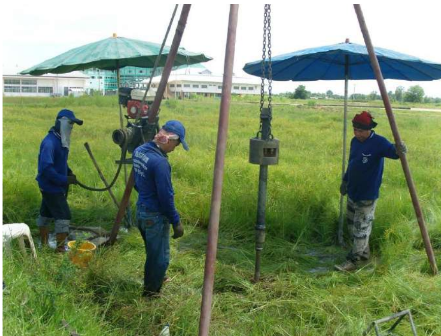
การสำรวจดิน เพื่อตรวจสอบการรับน้ำหนักของชั้นดิน (2)
