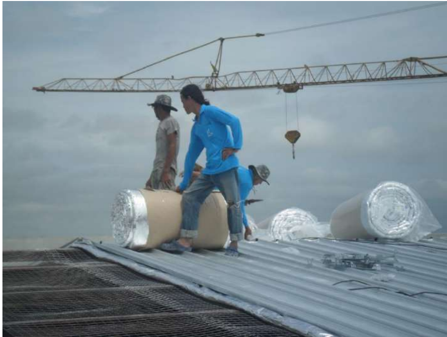
การวางฉนวนกันความร้อนพร้อมมุงด้วย หลังคาแผ่นเหล็กรีดลอน
