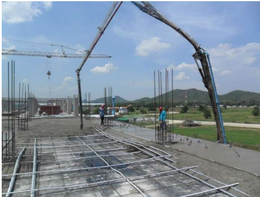
การเทคอนกรีต เหน้ที่แบบ มีคนงานจ้คอนกรีต
