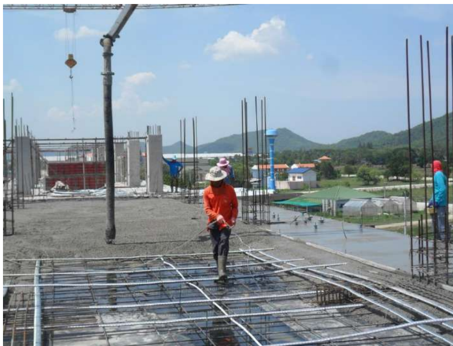
การเทคอนกรีต เหน้ที่แบบ มีคนงานจ้คอนกรีต (2)
