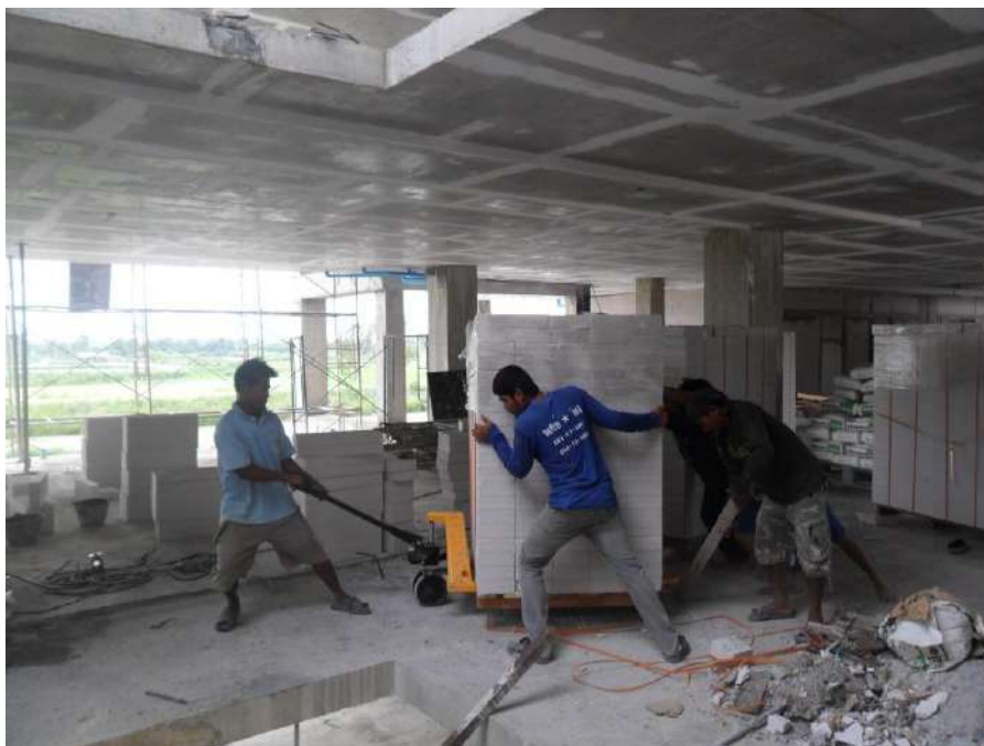
การเตรียมอิฐเพื่อก่อผนัง ควรขนย้ายด้วยอุปกรณ์
