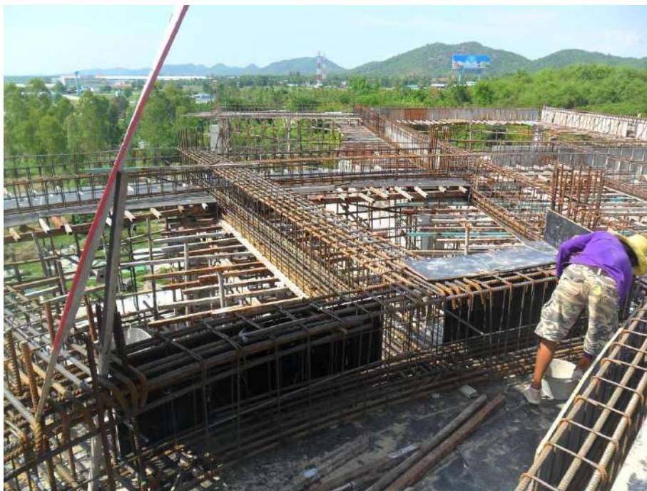
กรณีการวางเหล็กหลายทางให้ตรวจสอบในแบบพิมพ์เขียว
