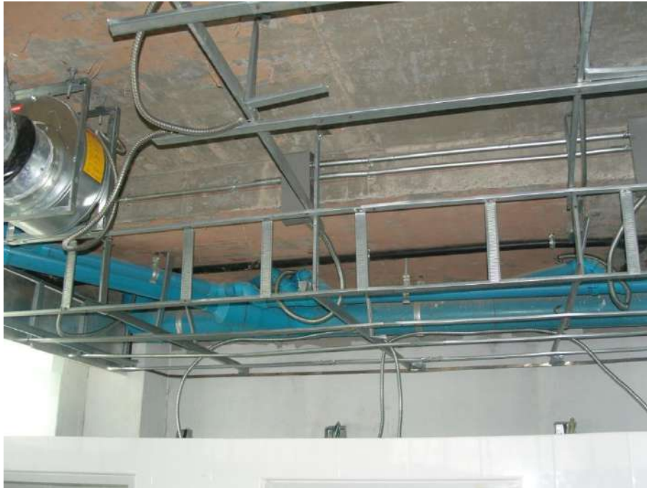
การวางงานระบบท่อประปา ไฟฟ้าให้ตรวจจากแบบงานระบบ
