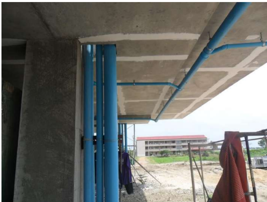
การวางงานระบบท่อประปา ไฟฟ้าให้ตรวจจากแบบงานระบบ (2)
