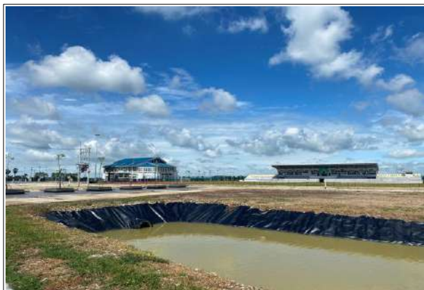
งานติดตั้งสระน้ำ อาคารศูนย์กีฬาในร่ม
