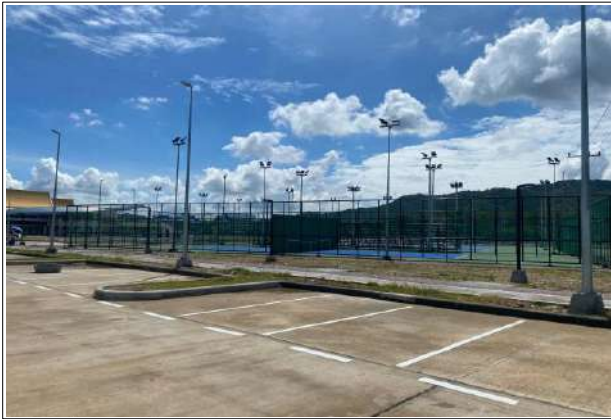
งานแก้ไขเก็บรายละเอียดพื้นอัฒจันทร์ อาคารศูนย์กีฬาในร่ม
