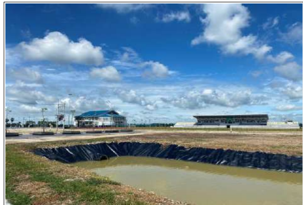
งานติดตั้งน้ำ อาคารศูนย์กีฬาในร่ม
