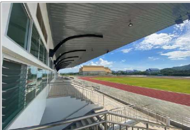
งานอาคารอัฒจันทร์ประธาน
